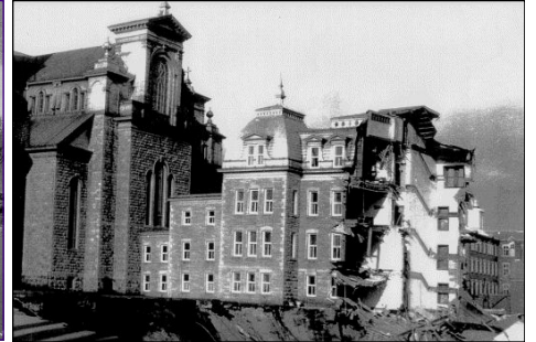
L'évêché s'est coupé en deux. En arrière-plan, la cathédrale, bien qu'épargnée par le désastre, a dû être démolie à cause de sa proximité du cratère.
